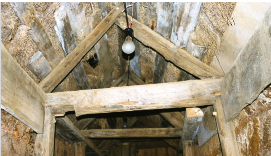
3. mynd. Úr göngum. Hér má sjá muninn á syllum og lausholtum. Nær má sjá ílangar syllur sem felldar eru í stoðirnar. Þetta eru einu hreinu leifar stafverks sem til eru í Laufásbæ. Fjar sitja lausholt ofan á stoðum. Ljós m. Guðrún Harðardóttir.
