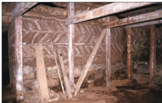
48. Horft inn eftir norðurvegg fyrir viðgerð. Ljós. Guðrún Harðardóttir.
