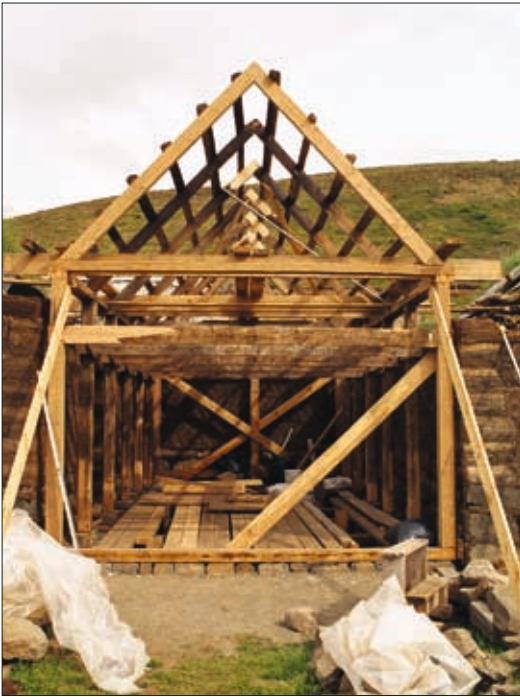
61. Timburgrindin eftir viðgerðir, áður en leirkennður jarðvegur var borinn á nýja viðinn. Ljós. Guðrún Harðardóttir.
