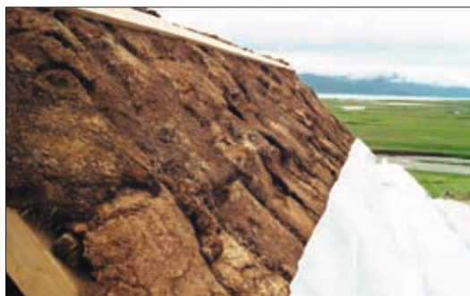
63. Þakdúkur lagður u.þ.b. 1 m upp á nærtorfið. Efst sést í lista til að negla í bárujárn. Ljós. Helgi Sigurðsson.
