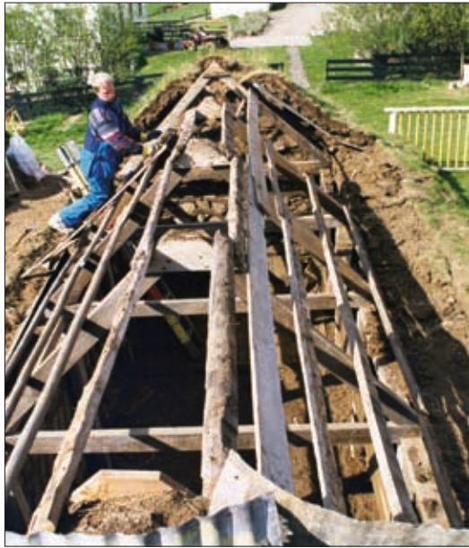
40. mynd. Horft norður eftir búri eftir að búið var að fjarlægja áreftið. Fyrir miðri mynd sést hvernig búið var að negla styrkingarspjöld á sperrutoppa. Til hliðanna sér í heilleg langböndin. Ljós. Guðrún Harðardóttir.
