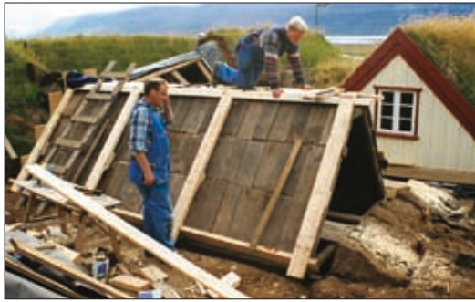
36. mynd. Yfirþak á brúðarhúsi hvílir á sperrum hússins og tekur á sig þyngd þekjunnar af viðkvæmum reisifjöllum. Ljós. Birkir Björnsson.
