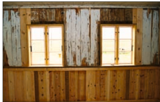
14. mynd. Vesturveggur vesturstofu að viðgerð lokinni. Af spjaldþiljum hefur nokkuð verið endurnýjað en meira er um að gert hafi verið við efri þiljur. Ljós. Guðrún Harðardóttir.
