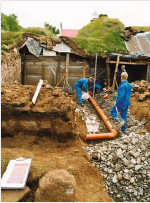
29. mynd. Undirstöður veggjarins milli búrs t.v. og brúðarhúss t.h. Loftblástursrörið er appelsínugult á lit en frárennslisrörin grá. Ljós. Guðrún Harðardóttir.
