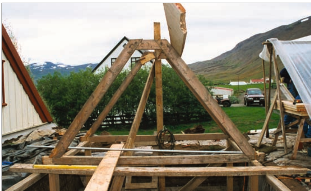
35. mynd. Kálsperrur brúðarhúss endurreistar eftir viðgerð. Þær þurftu sáralítilla viðgerða við. Ljós. Guðrún Harðardóttir.
