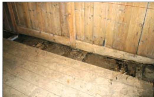
25. mynd. Við austurvegg brúðarhúss. Hér sést hvernig gólfbitar lágu ofan í mold og hversu nærri gólfjalir voru jarðveginum. Ljós. Guðrún Harðardóttir.
