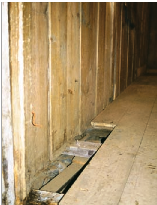
32. mynd. Horft inn í brúðarhús. Fjölin V-15 er lengst til vinstri og ber í appelsínugulan bandspotta. Hún er greinilega lengri en aðrar fjalir hússins. Ljós. Guðrún Harðardóttir.
