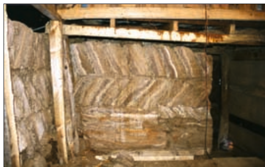
22. mynd. Suðurgafleggur brúðarhúss. Neðst í veggnum má sjá leifar strenghleðslu. Stórgerða hleðslan ofan til er líklega frá viðgerðinni 1976-78. Ljós. Guðrún Harðardóttir.
