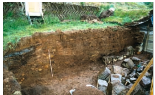
41. mynd. Snið sem birtist þegar austurveggur búrs hafði verið fjarlægður. Þetta snið var síðar dýpkað um 80 cm og veggurinn byggður upp tvöfaldur. Ljós. Guðrún Harðardóttir.
