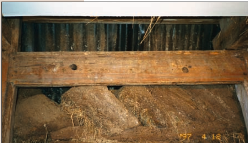
7. mynd. Lausholt í stofugrind sem hefur haft annað hlutverk áður fyrir. Barok-strik er meðfram báðum jöðrum. Ljós. Kristján Pétursson.
