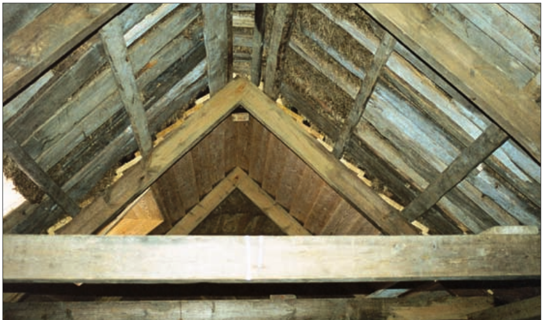
45. mynd. Horft upp í rjáfur búrs eftir viðgerð 1998. Fyrir miðri mynd er næstnyrsta sperruparið og sést viðgerð í toppi þess vel. Á bak við sést í endurnýjað nyrsta sperruparið og skarsúðina í innsta stafgólfinu. Neðst til hægri sést í viðgerð á bita. Ljós. Guðrún Harðardóttir.
