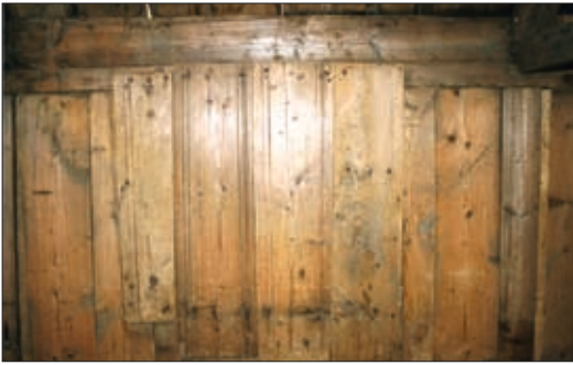
23. mynd. Fjalir með strikum á sem negldar voru yfir gluggaop á vesturvegg brúðarhúss. Ljós. Guðrún Harðardóttir.
