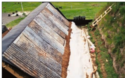
64. Bárujárn lagt yfir vindpappa, neglt fast við lista eftir mæni hvorum megin. Neðst má sjá n.k. torfbólstur sem koma á í veg fyrir að bárujárnið geti nuðast við þakdúkinn.
