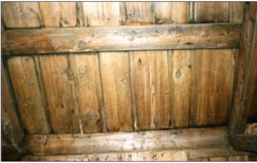
18. mynd. „Reisifjöl“ í brúðarhúsi eins og hún lítur út innan frá. Margar fjalanna eru prýddar strikum til skrauts. Ljós. Guðrún Harðardóttir.
