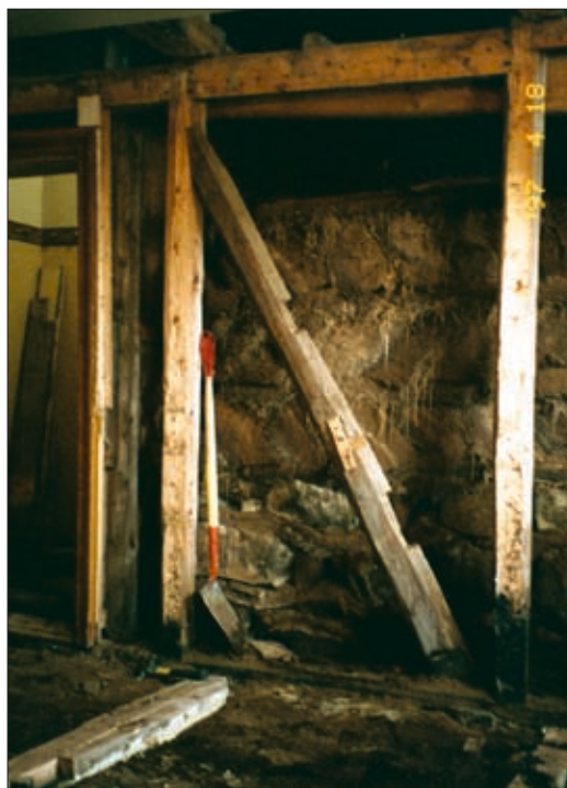
6. mynd. Suðurveggur vesturstofu. Hér sést skakkstífa sem hefur haft annað hlutverk áður en hún var notuð í stofugrindina. Ljós. Kristján Pétursson.
