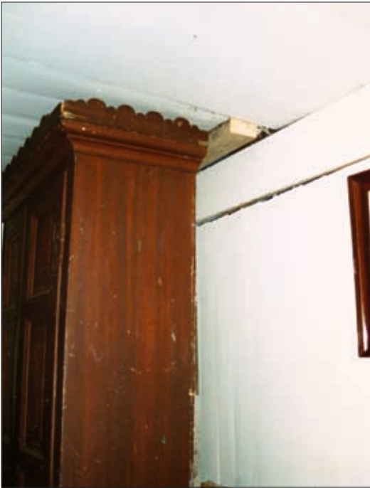
9. mynd. Skápur við austurvegg austurstofu. Vegna þess að burður var farinn úr veggjum hvíldi hluti af þunga hússins á honum áður en viðgerð hófst 1997. Ljósmynd. Hjörleifur Stefánsson.
