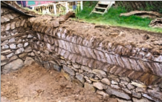
39. mynd. Norðausturhorn búrs. Á kafla fyrir miðri mynd er ekki torf inn á milli í steinhleðslu austurveggjar. Ljós. Guðrún Harðardóttir.
