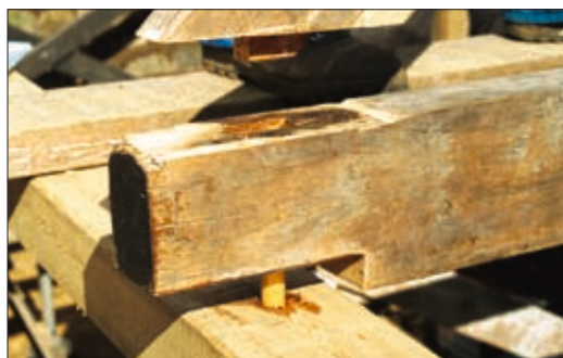
44. mynd. Samskeyti bita, sperru og lausholts í búi. Fúavarnarefni var borið inn í samskeytin. Ljósni. Guðrún Harðardóttir.
