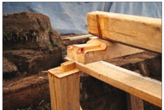
60. Samskeyti stoðar, lausholts og höfðubita í suðausturhorni dúnhúss. Ljósmynd. Guðrún Harðardóttir.
