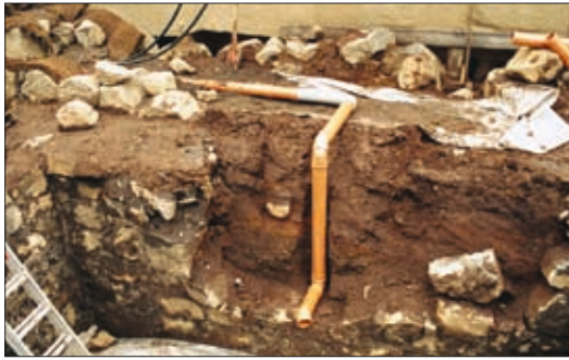
53. Suðurveggur kjallara. Hér sést sniðið sem birtist í veggrofinu og loftblástursrör sem lagt var inn í vegginn. Ljós. Guðrún Harðardóttir.
