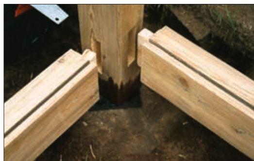
33. mynd. Frágangur á neðri hluta grindar í brúðarhúsi. Þverslár með raufum fyrir þiljur eru tappaðar inn í stoðir. Tjörupappi liggur milli stoðar og stoðarsteins og fúavarnarefni var jafnframt borið á stoðarendann. Hvort tveggja gert til að teffa fyrir fúamyndun í stoðinni. Ljós. Guðrún Harðardóttir.
