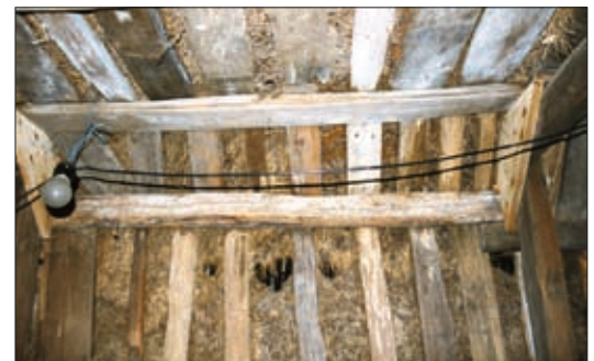
38. mynd. Horft upp í rjáfur búrs fyrir viðgerð. Milli efstu langbanda hvoru megin eru lagðir viðir sem kalla mætti „áreftiskálfa“. Ljós. Guðrún Harðardóttir.
