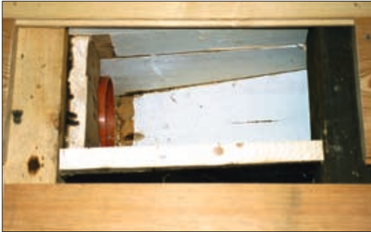
13. mynd. Frágangur við enda loftblástursrörs í stofu. Búið var svo um hnútana að hægt væri að koma loftstreymi milli þilja og torfveggjar ef þurfa þykir. Ljós. Guðrún Harðardóttir.
