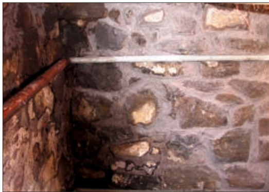
54. Suðausturhorn kjallara eftir að búið var að múra milli steina. Hér sést einnig járnspöngin sem höfð var til öryggis í kjallaranum fyrst um sinn. Lengst til vinstri glittir í eldri múr. Ljós. Sigurður Bergsteinson.
