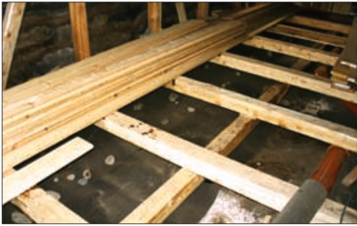
12. mynd. Loftblástursrör úr plasti kvíslast í báða enda stofuhússins. Undir gólfbitum sést í tjörupappa sem lagður var ofan á jarðveginn til varnar fúa. Ljós. Guðrún Harðardóttir.
