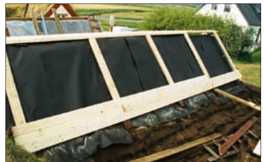
46. mynd. Gerð yfirþaks á búri. Undir þakpappanum er vallendistorf sem liggur ofan á gamla árefti búrsins. Yfirþak brúðarhúss er sambærilegt að gerð, þ.e. yfirsperrur liggja á klossum sem festir eru í sperrur og langbönd og súðarborðin fest á sama hátt og myndin sýnir. Ljós. Birkir Björnsson.
