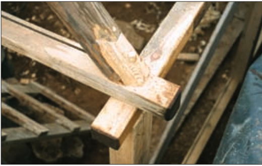
34. mynd. Dæmi um viðgerðir á efri hluta brúðarhússgrindar. Hér getur að líta viðgerðir á bita, lausholti og sperru í norðvesturhorni brúðarhúss. Ljós. Guðrún Harðardóttir.
