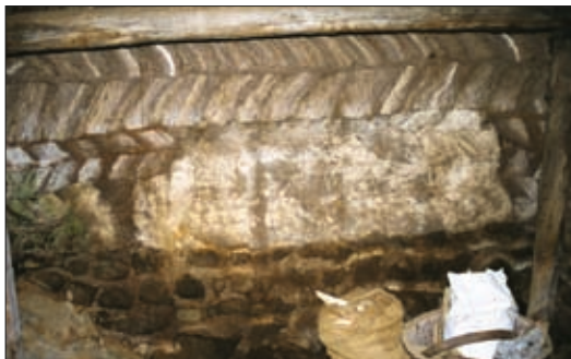
27. mynd. Suðurveggur eldhúss. Klömbruhleðslan er mun smágerðari neðar í veggnum en ofar. Efri hleðslan er líklega frá viðgerðinni 1976-78 en sú neðri gæti verið nokkuð gömul. Hvíta skánin á neðri hluta veggjarins bendir til þess að hann sé frá búsetutíma Laufásbæjar eða fyrir 1936. Ljós. Guðrún Harðardóttir.
